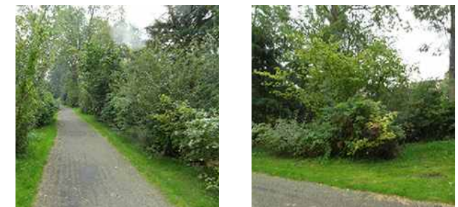
Figuur 2.27: Foto's bestaande situatie vak 5
